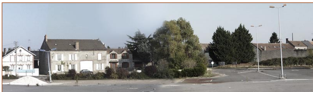
L'espace délaissé après le sinistre incendie.
